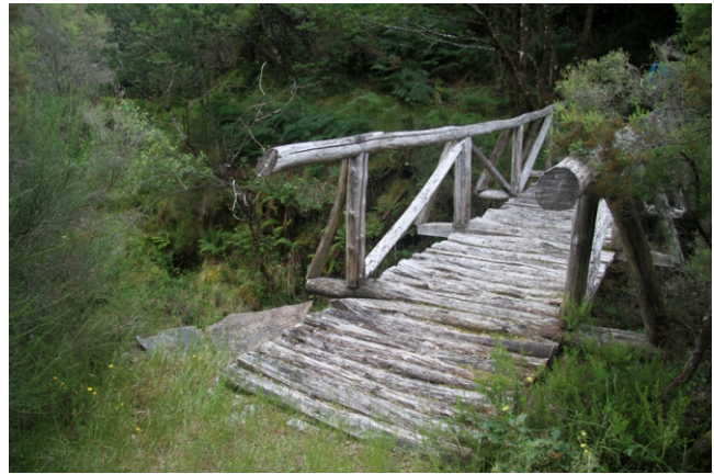
Ponte das Arandainas
